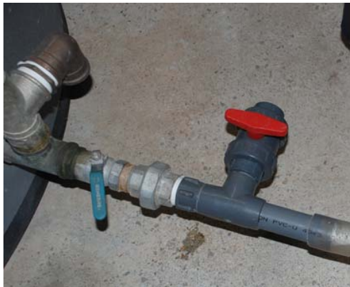
Aixeta per presa de mostra d'aigua del fons de l'acumulador
